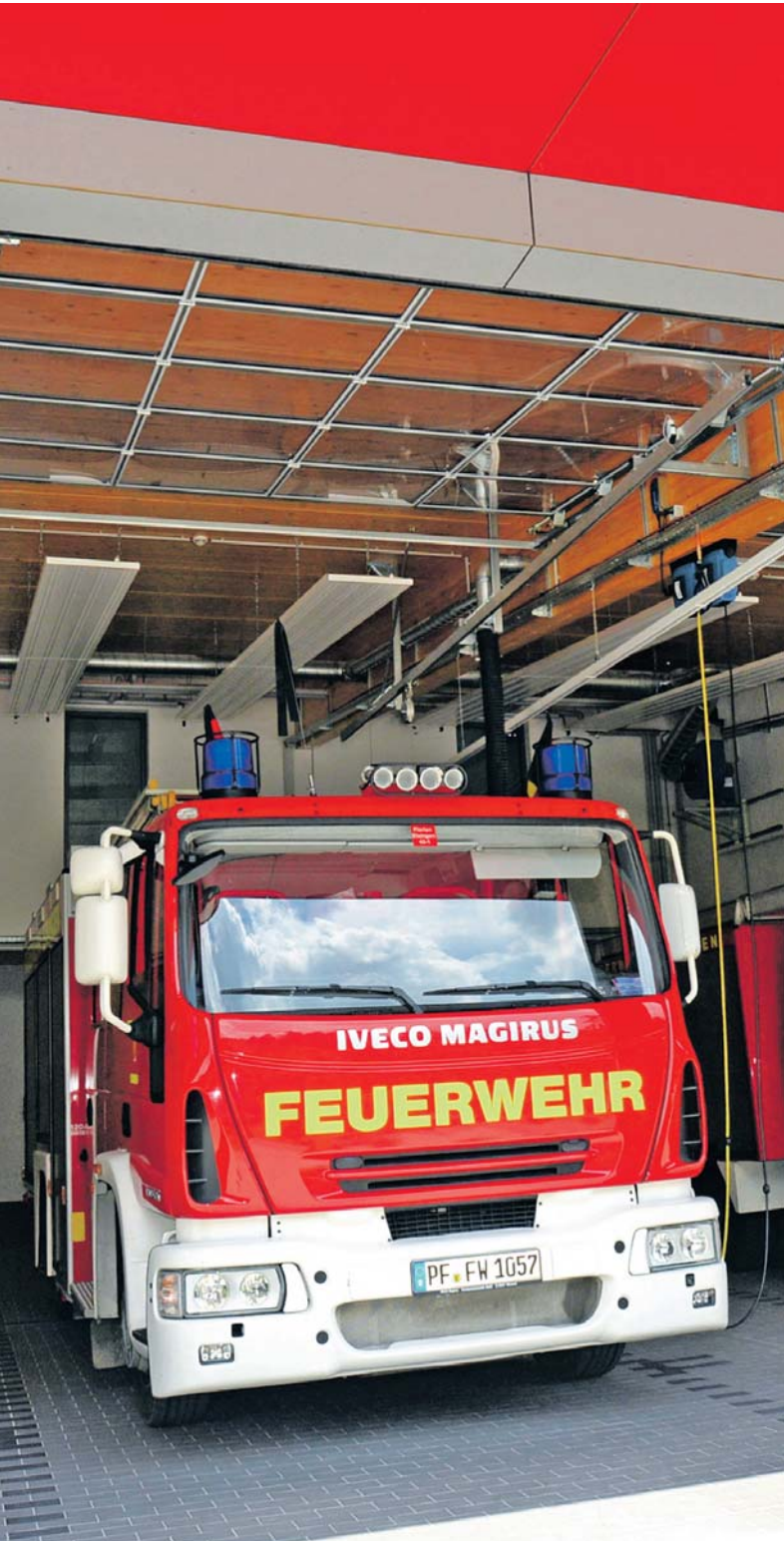
Die Technik in der Fahrzeughalle ermöglicht einen zügigen Start der immer einsatzbereiten Löschfahrzeuge und des Mannschaftswagens.
