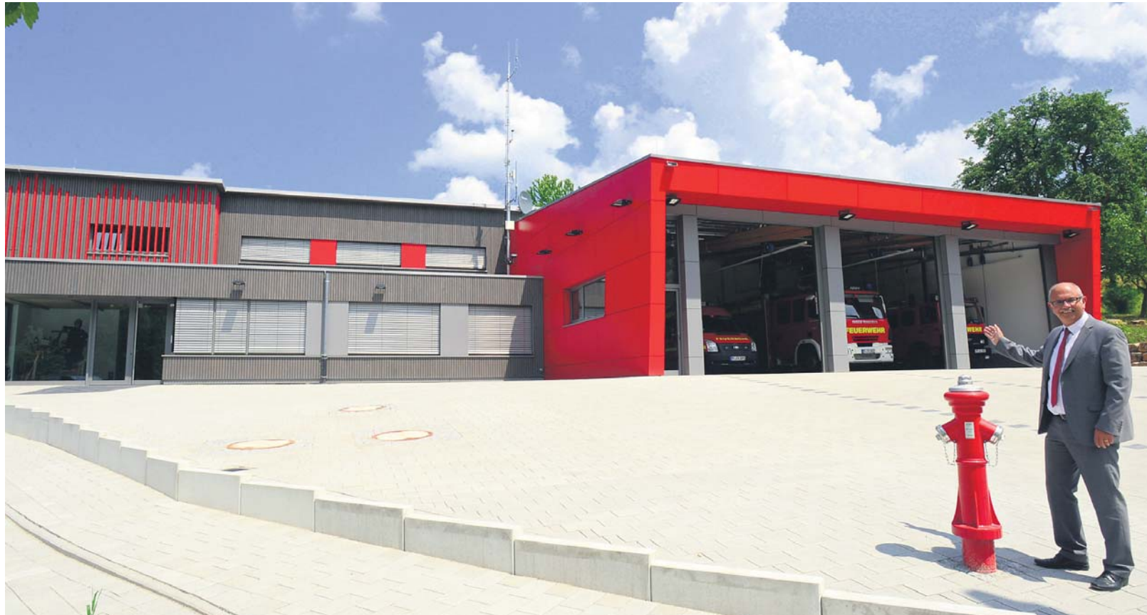
Die Südseite des Feuerwehrgerätehauses mit den Führungsräumen (links) und der dreiteiligen Fahrzeughalle, davor das Zufahrts- und Übungsgelände; rechts Bürgermeister Thomas Karst.
